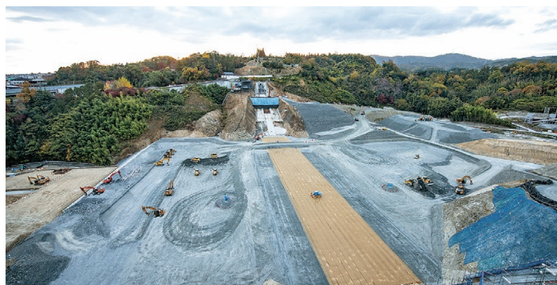
安威川ダムの工事（大阪府所在）
